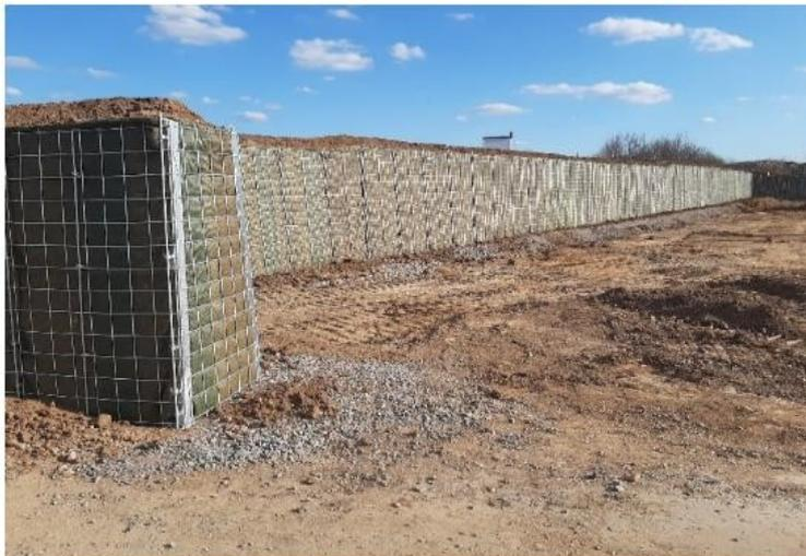
Zur Verringerung der Straßen-Verkehrsgläusche der angrenzend verlaufenden B 477 wird eine 2.30 m hohe Lärmschutzwand als aktive Lärmschutzmaßnahme festgesetzt. Die Lärmschutz-wand wird von beiden Seiten begrünt. In den Zülpicher Seegärten wurde an der B
