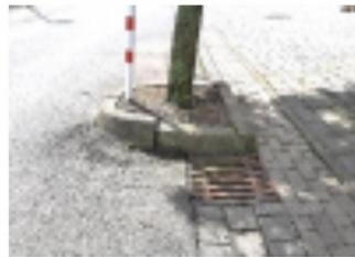
Die Baumscheibe mit einem Durchmesser von 90 cm ist auseinander gebrochen. Der Asphalt bläht auf.
