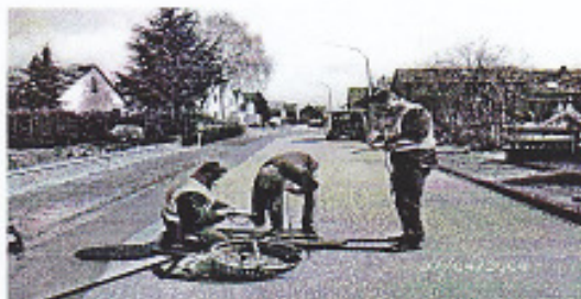
Prüfung des Kanals im Straßenbereich.
